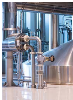
Bereinigung von Bierleitungen
